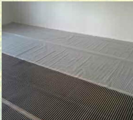
Schutzfolie zwischen Heizfolie und Fußbodenbelag (Gleitschicht)
